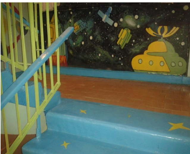
Фото №7 Пути движения внутри здания (лестничный пролет на 1 этаж)
