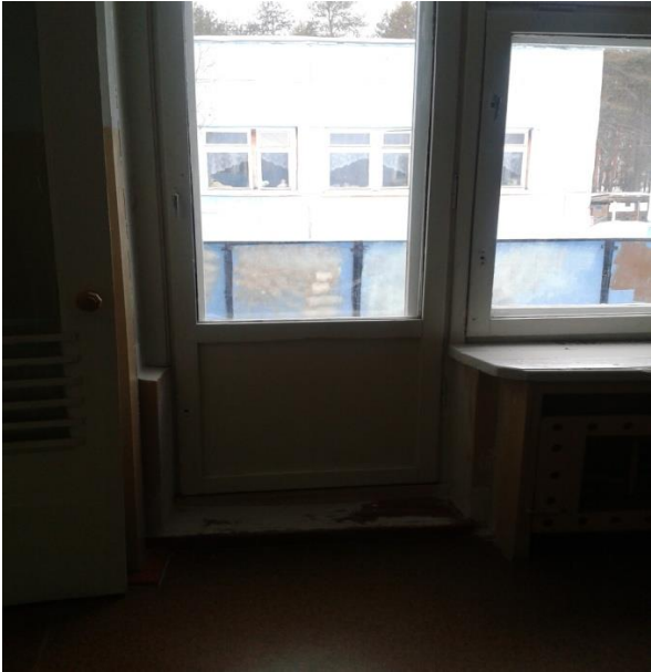
Фото №31 Пути движения внутри здания (пути эвакуации: спорт.зал)
