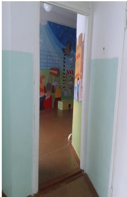
Фото №29 Пути движения внутри здания (пути эвакуации: спорт.зал)
