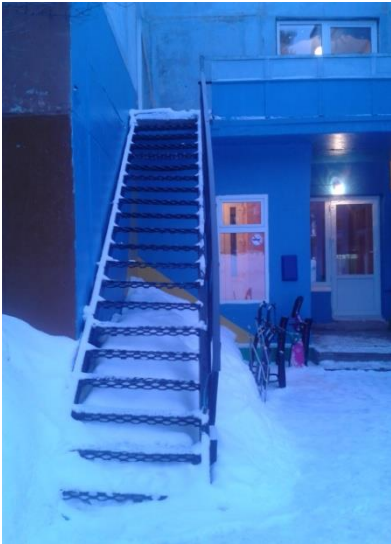
Фото №1 Эвакуационная лестница
