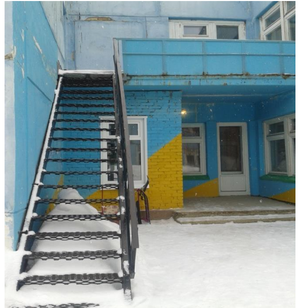
Фото №32 Пути движения внутри здания (пути эвакуации: спорт.зал)
