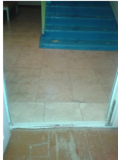
Фото №5 Пути движения внутри здания (вход)
