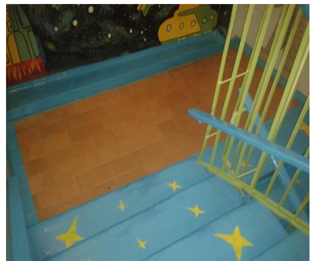
Фото №8 Пути движения внутри здания (лестничный пролет на 2 этаж)
