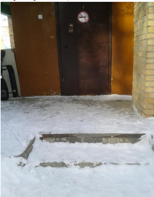
Фото №11 Вход в здание ясельной группы (дверь)
