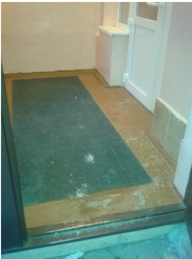
Фото №4 Вход в здание (тамбур)
