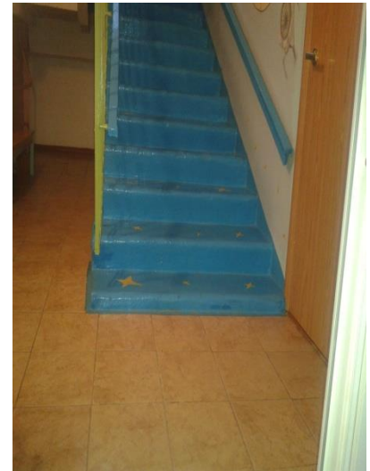
Фото №6 Пути движения внутри здания (лестница)
